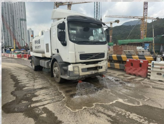
定時以水車灑水防止塵土飛揚
