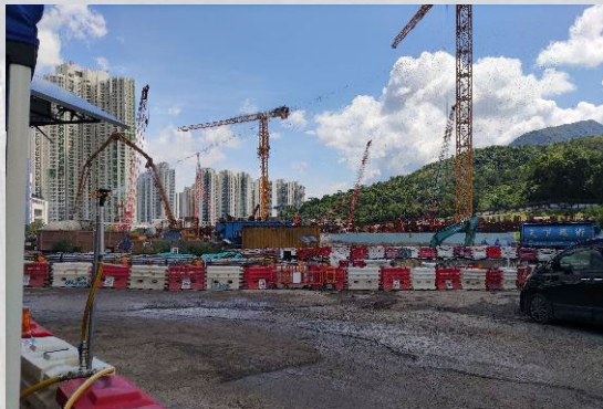
定時於工地進行灑水防止塵土飛揚
