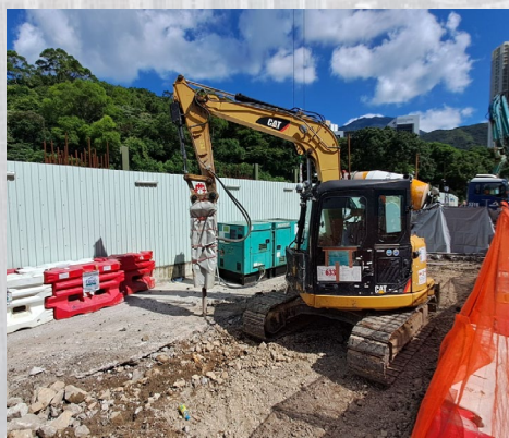
使用隔音布包裹破碎錘
