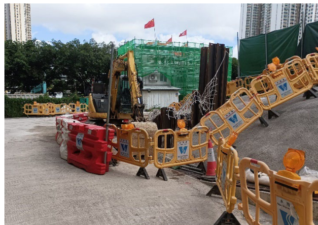
水務署完成水管維修及測試(10月11日)
