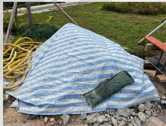
以帆布遮蓋建築物料防止塵土飛揚
