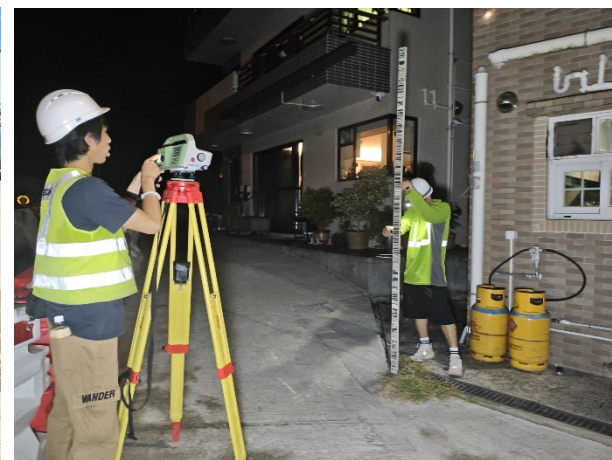
土木工程拓展署即時安排二十四小時監察土地沉降和樓宇傾斜
