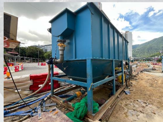
設置污水處理設施
