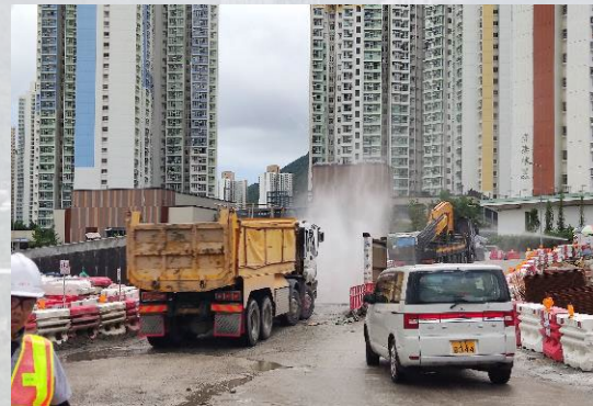
地盤出口設立洗車設施
