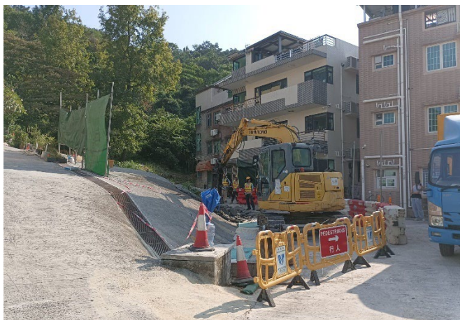
水務署完成緊急供水調度及測試後，立刻開展水管維修(10月9日)
